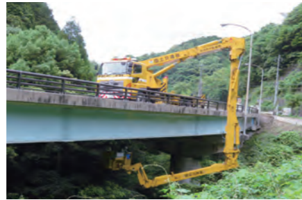
橋梁点検車による橋梁点検
