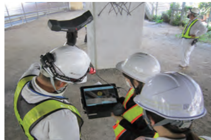
ハンディスキャナによる橋梁点検
