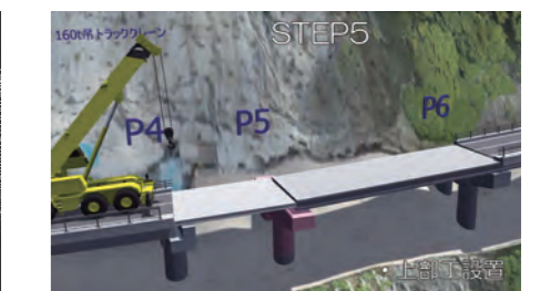
被災橋梁の復旧計画
