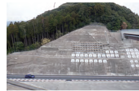
法面斜面地すべり対策
