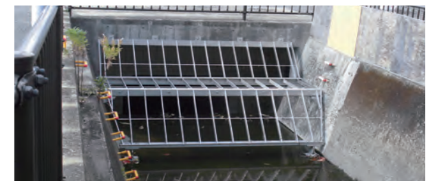
浸水対策 水路スクリーン改良
