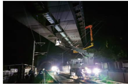
軌陸車、橋梁点検車による橋梁点検
