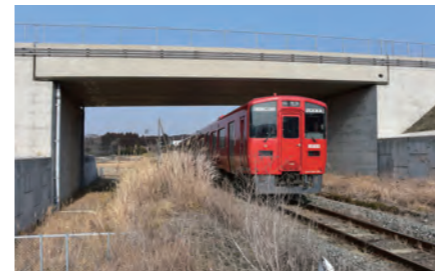
北側復旧ルート 赤水橋
