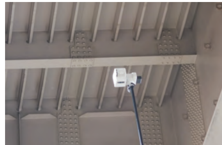
ロボットカメラによる橋梁点検
