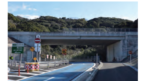
西九州自動車道 調川11号橋
