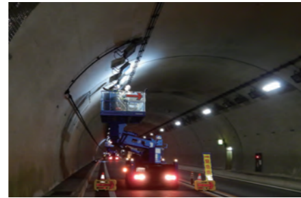
高所作業車によるトンネル点検
